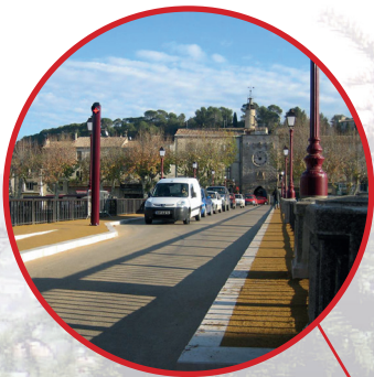
Elargissement des trottoirs ▲ du Pont Tibère et feu tricolore
