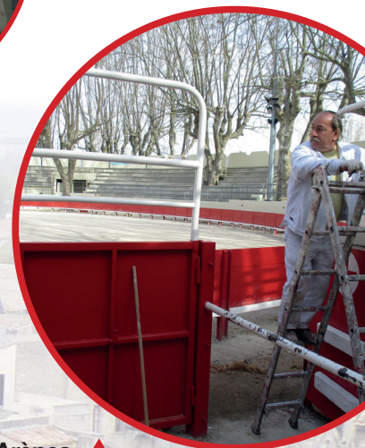
▲ Réfection des Arènes
