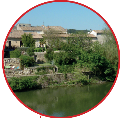
Stabilisation et plantation des berges du Vidourle
