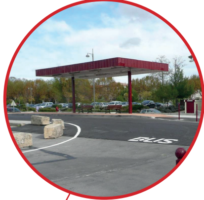
◀ Déplacement et aménagement de la gare routière
