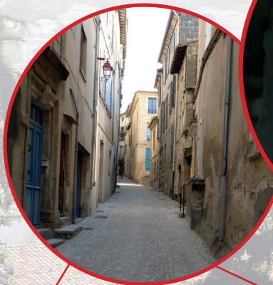
Aménagement de la rue Taillade
