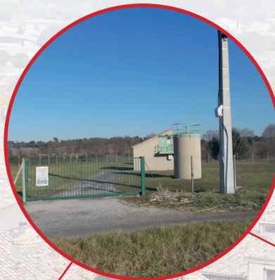
Nouveau forage d'eau potable à Saint-Laze et extension du ▼ réseau d'eau potable
